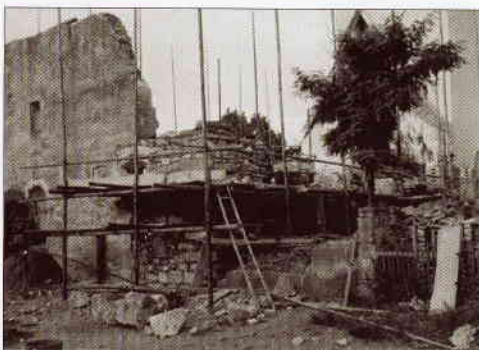
Das nach Süden erweiterte Kirchenschiff macht eine neue Südwestecke erforderlich.
