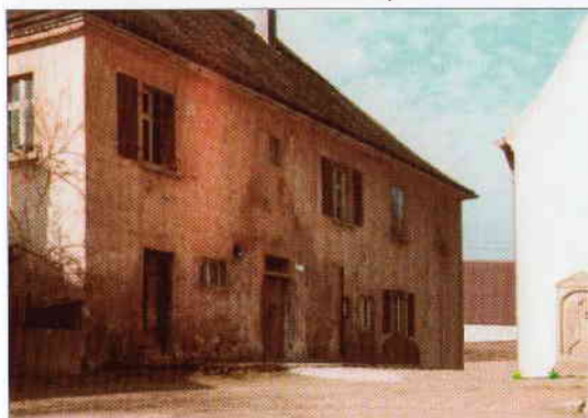
Kurz vor Beginn des Umbaus: das „alte Schulhaus“
