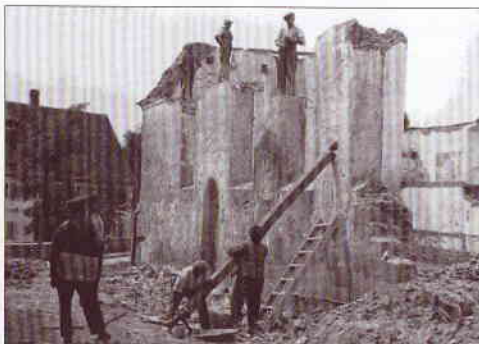
Die Südwand wird abgebrochen.
