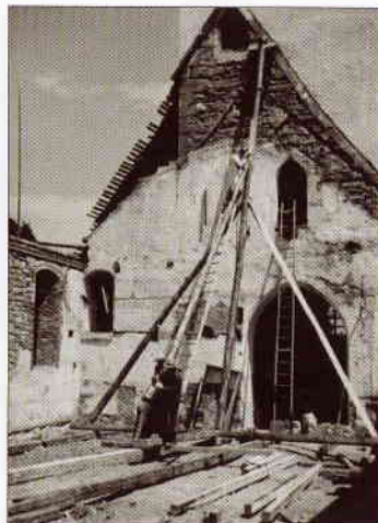
„Abbinden“ des Dachstuhl
