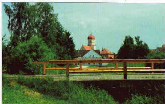
Brücke über den Hammerschmiedbach seit 1975 Bild o. Erna Weidenbacher M; Foto u. 2000
