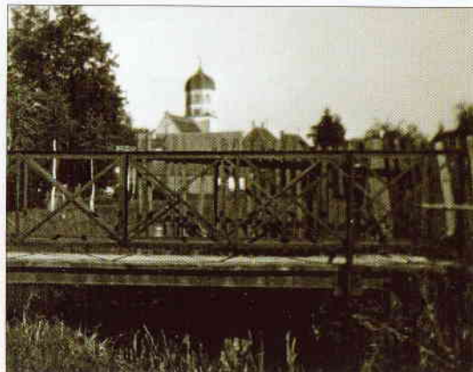
Der alte Steg über den „Katzenbach“ Mitte 1950er und die neue, massive
