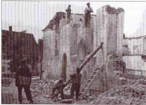
Die Südwand wird abgebrochen.
